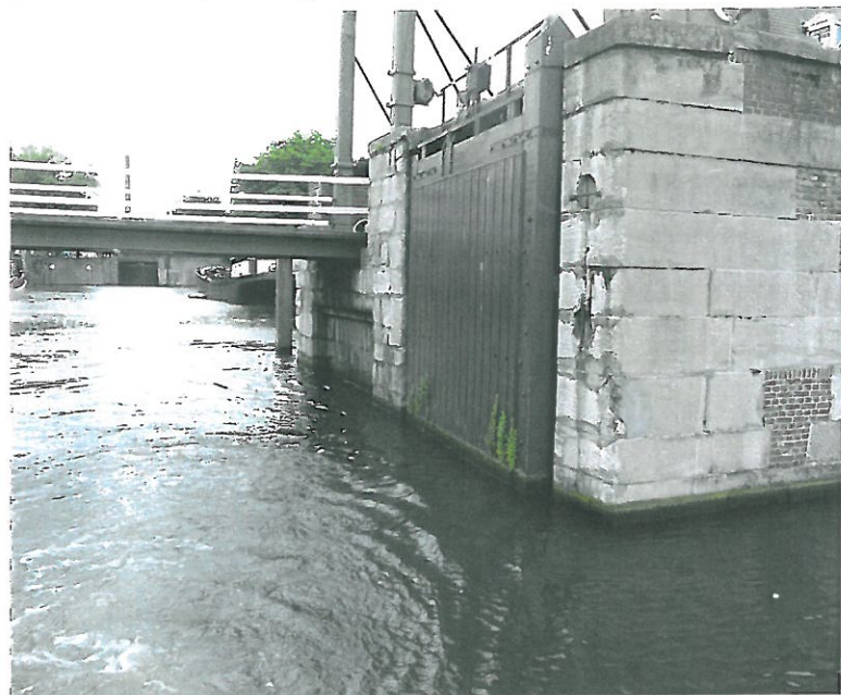
Veel hout in Delfshaven, sluisen, steigers, dekken, palen en damwanden en heipalen onder kademuren.
