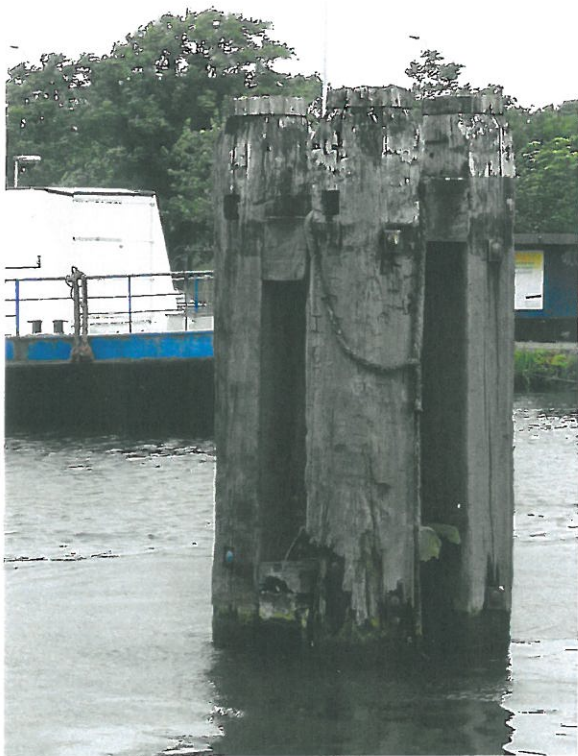
Grote oude paaljukken op de Schie waar te zien is wat de consequenties zijn van de vroeger veel gebruikte detailleringen.
