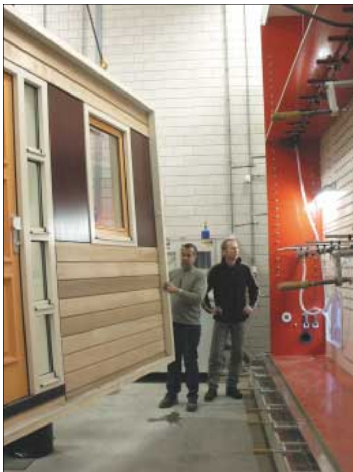
Plaatsen van het element voor de kast.
