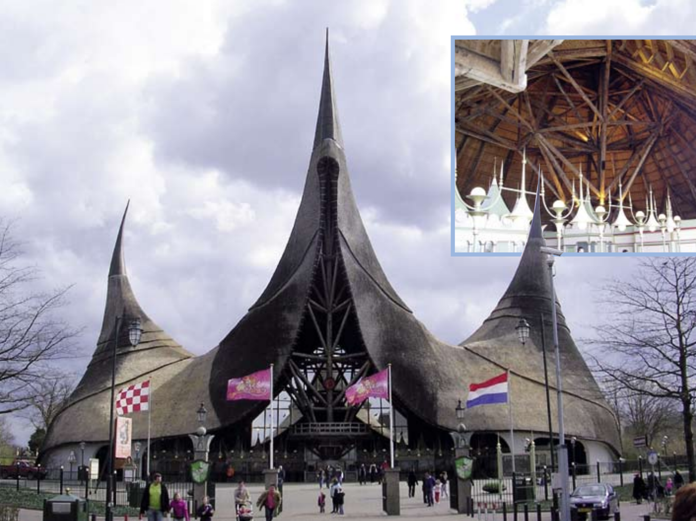
Het entreegebouw van de Efteling is een goed voorbeeld van een modern gebouw met een rondhoutconstructie.
