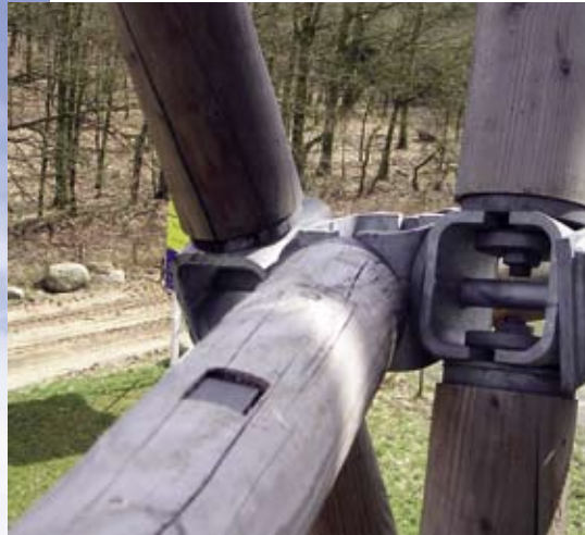
Staalblok bevestigd aan bout.
