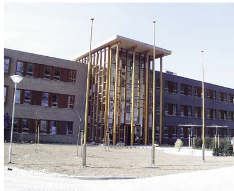
Het Cambium heeft rondhoutconstructies van gelijmde gelamineerde elementen.
