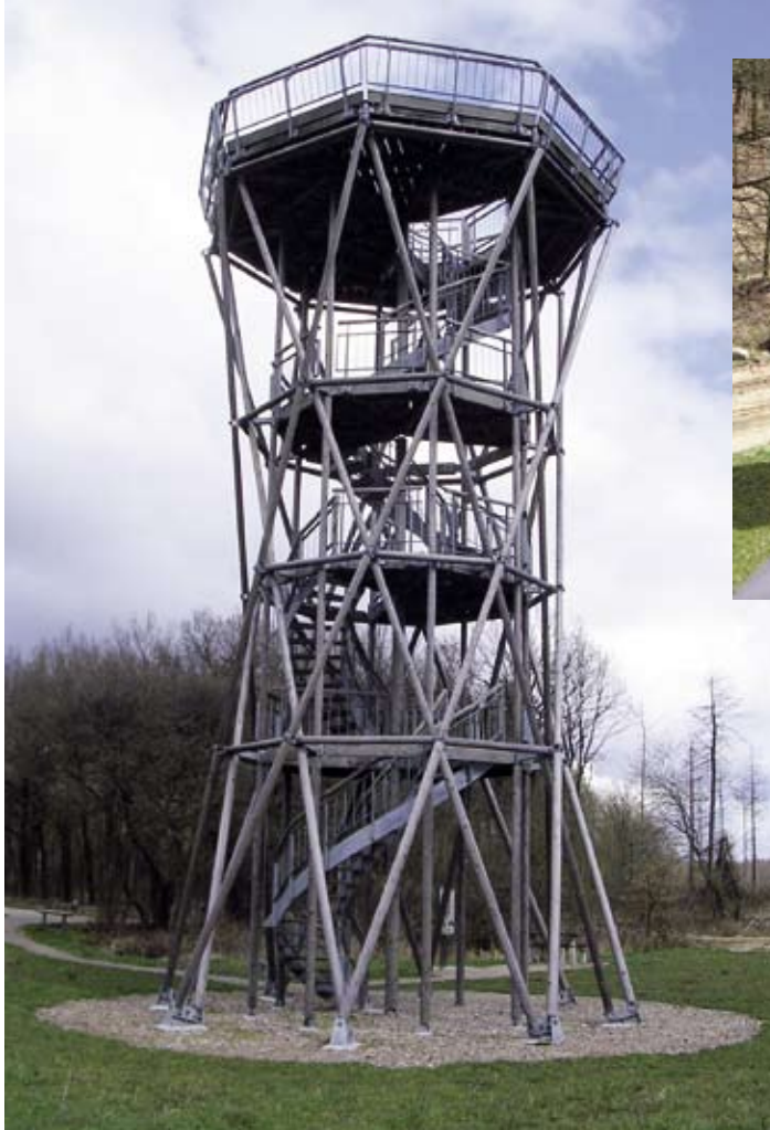
Wachtoren Natuurpark Holmers Halckenbroek. Gemaakt van kleine lariks elementen met gebruik van staalblokken.
