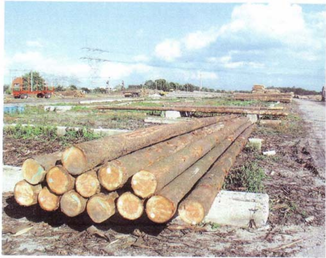
Opslag bij de heipalenleverancier
