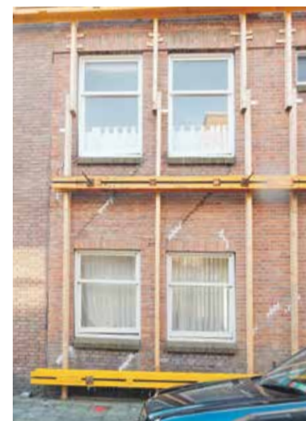
Hulpconstructie tegen te snelle onverwachte zakking.
