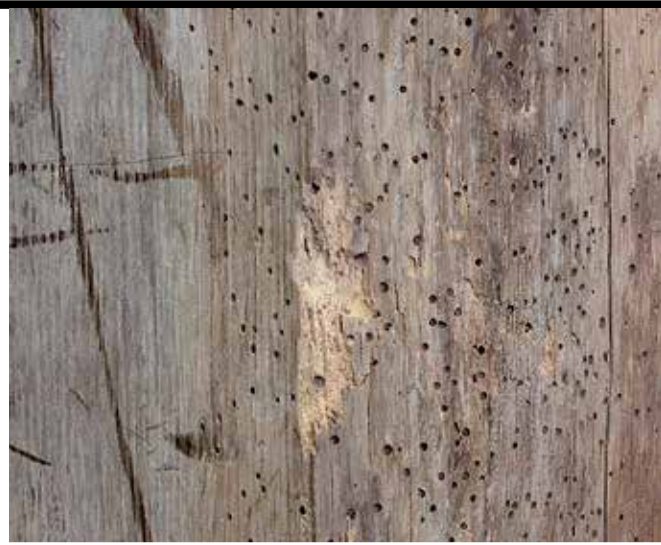
◀ Aantasting houtworm in eiken (foto: SHR).
