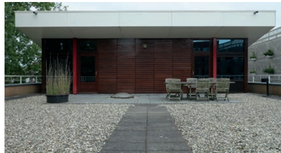
Dakterras met onder de witte aluminium daktrim de gevelbekleding van teak rabat.
