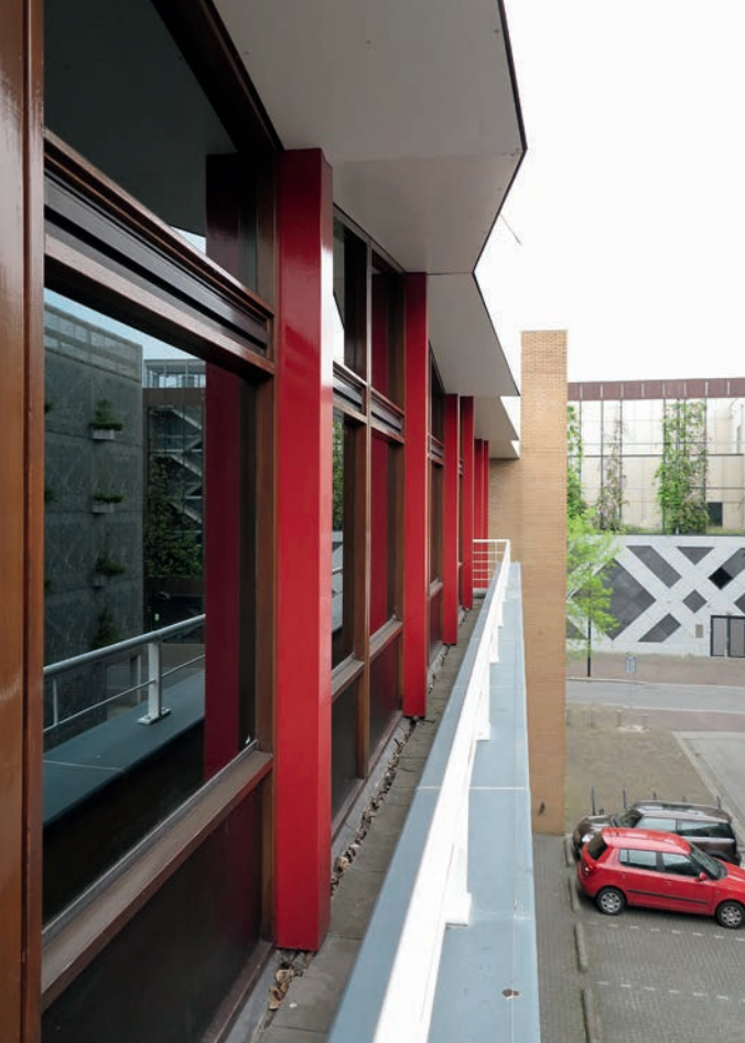
De gevelelementen op de 2e etage zijn goed benaderbaar voor onderhoud.
