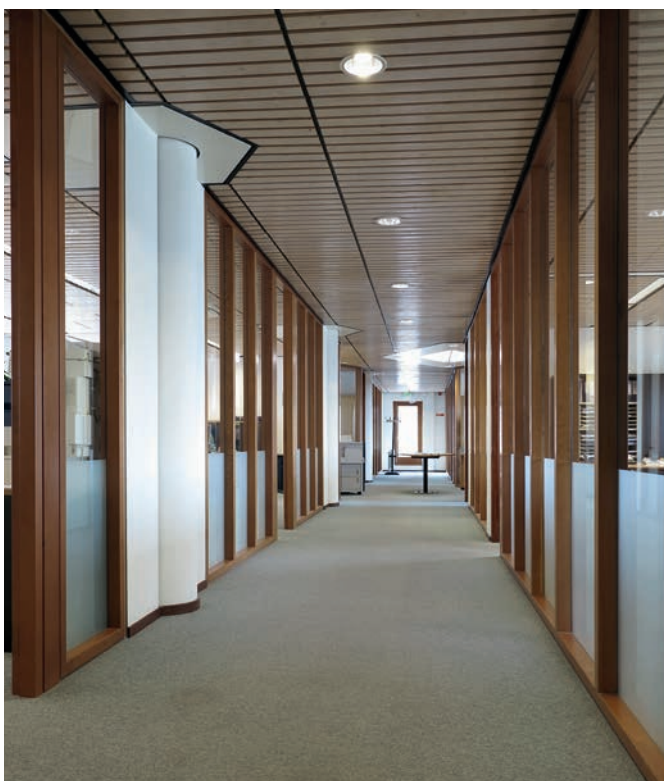
Gang 1ste verdieping met Oregon pine binnenkozijnen.
