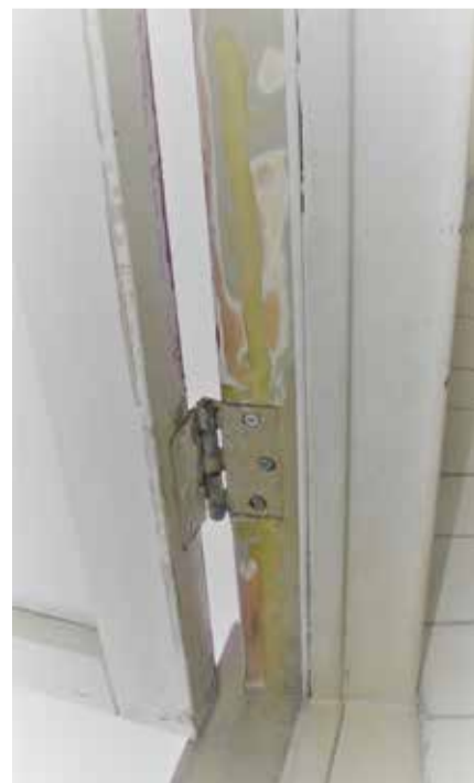
Reparatie van een deurkozijn.
