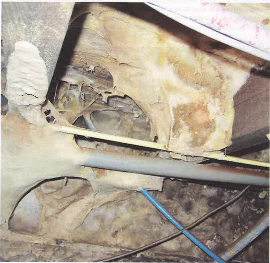
Huiszwam: vliezige groei onder vloer met sporenstof op leidingen
