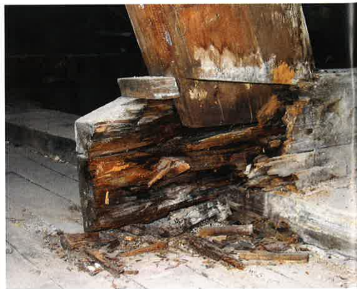
Sterk door huiszwam (bruinrot) aangetaste slof. Foto: SHR
