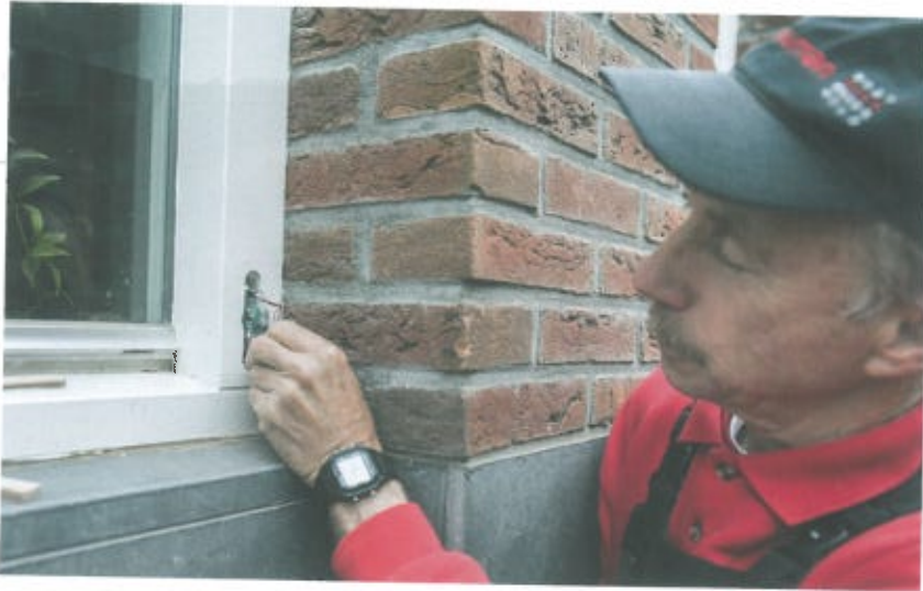
▲ De onderhoudssensor wordt geplaatst in een holte, vlak bij een verbinding, in het houten kozijn.
