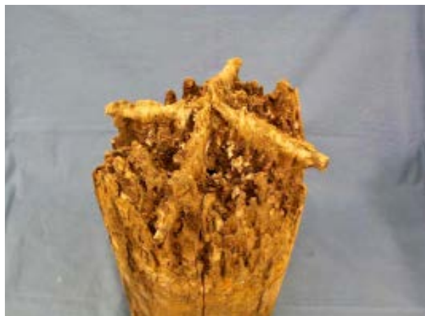
Funderingspalen onder sluis na 100 jaar in goede conditie.
