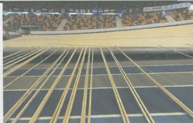
De Accoya latten liggen klaar. Door hun grote lengtes (van 5,40 of 6 meter) zijn minder latten nodig en zijn er dus ook minder 'stootvoegen'.
