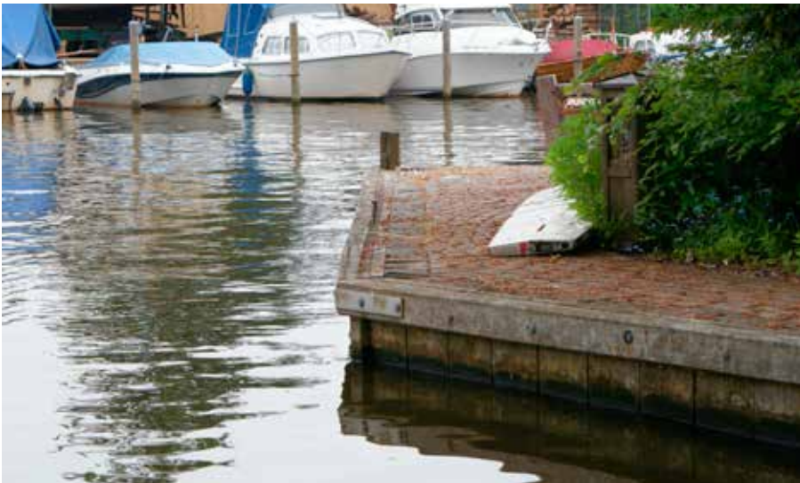
Ook in 2041 worden houten remmingswerken uit zware, harde en duurzame tropische hardhoutsoorten gemaakt.
