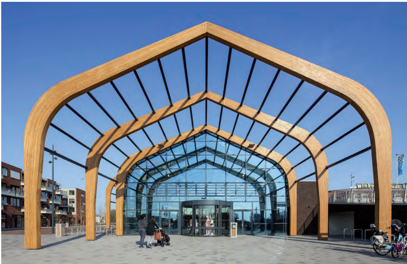
Goed en duurzaam lamineren en vingerlassen vormt de basis.
