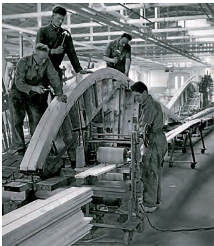
Fabricage van spanten bij Nemaho (collectie ECAL).
