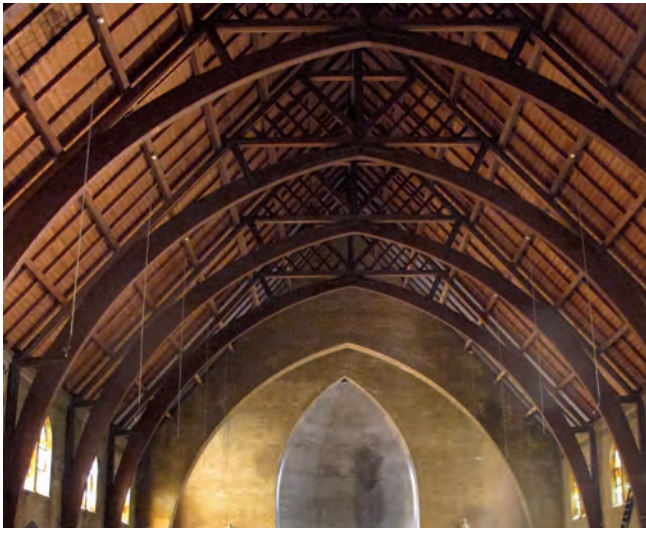
Spanten in de kapconstructie van een kerk. Het gelijmde gelamineerde hout is tevens genageld.
