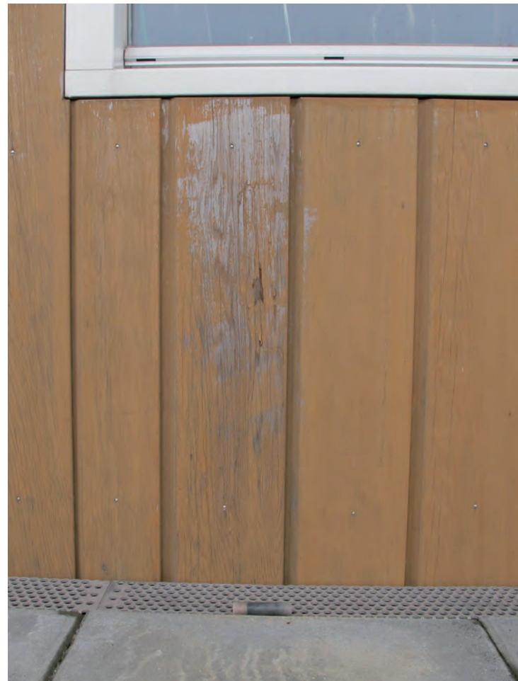
Verfshade bij brandvertragende behandeling.
