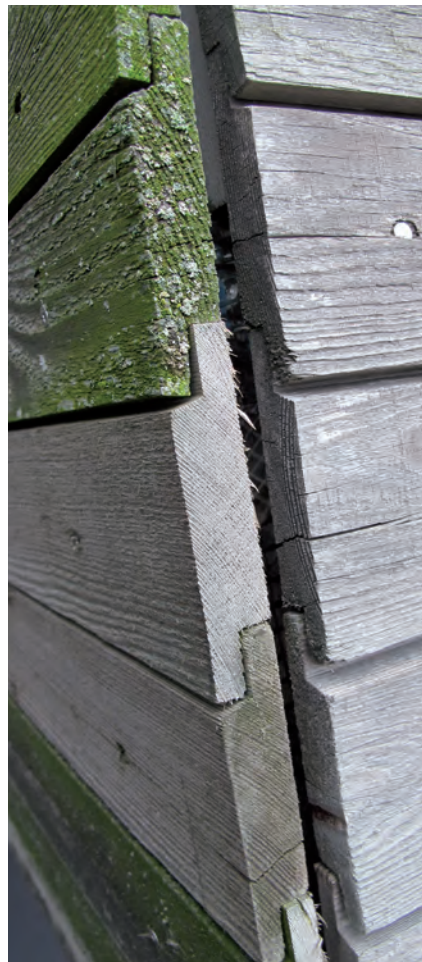
Te diep aangebrachte nagel en te natte houtdelen, met mos en algengroei tot gevolg.
